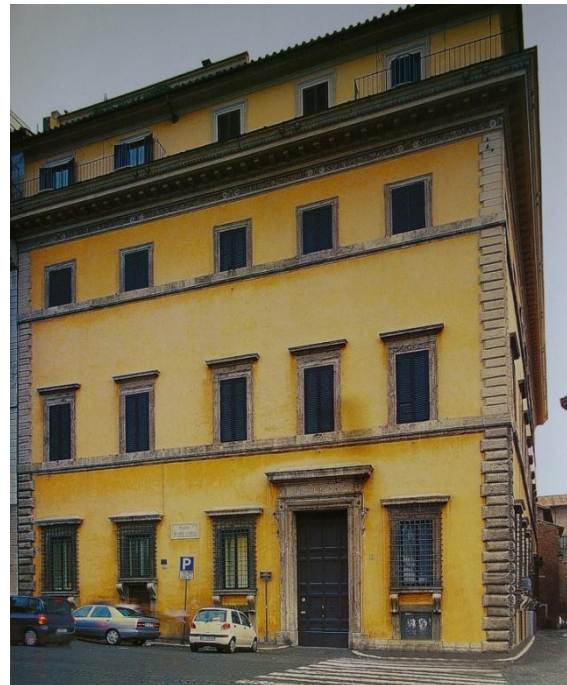
Abb. 26: Palazzo Fano, Fassade
