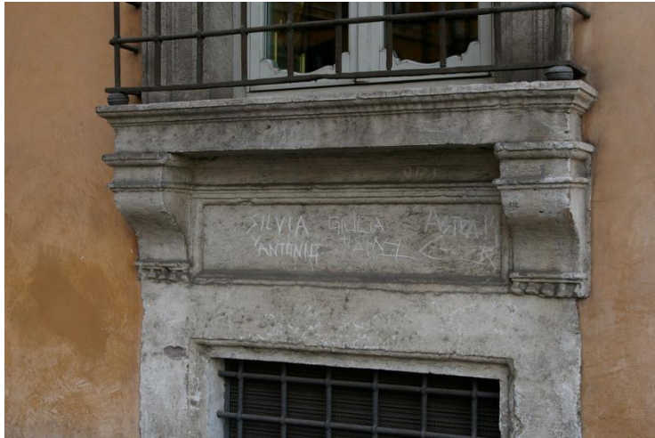
Abb. 28: Palazzo Muti-Bussi, Fassade, Erdgeschoss, Fenster
