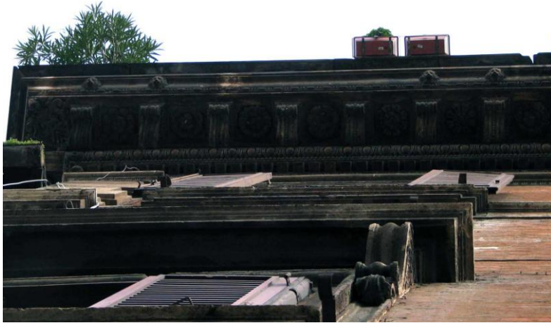
Abb. 33: Palazzo Capizucchi, Fassade, Gebälk
