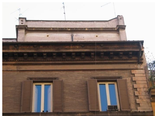
Abb. 10: Palazzo Ruggieri, Fassade, Kranzgesims
