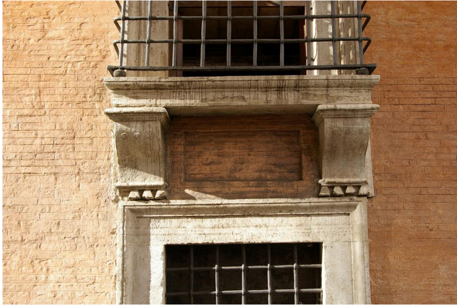
Abb. 30: Palazzo Altemps, Fassade, Erdgeschoss, Fenster
