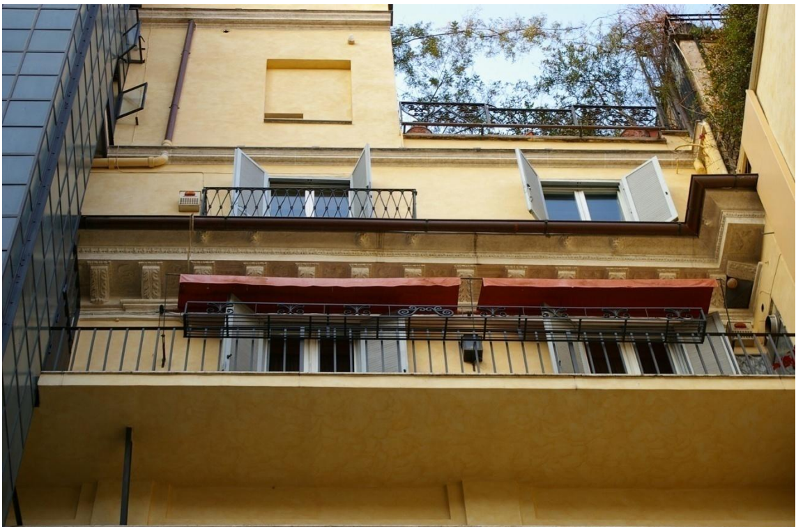
Abb. 47: Palazzo Ruggieri, Innenhof, Loggia, zweites Obergeschoss
