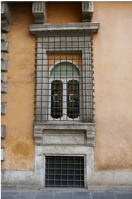
Abb. 25: Palazzo Muti-Bussi, Fassade, Erdgeschoss, Fenster
