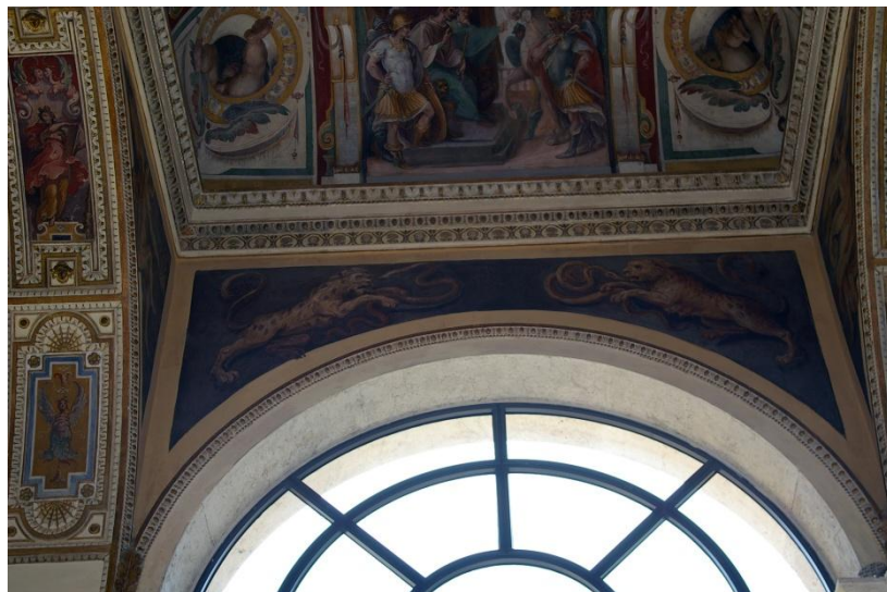
Abb. 99: Palazzo Ruggieri, Piano Nobile, Loggia, Wappentiere
