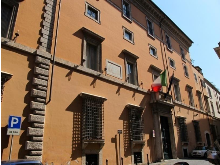
Abb. 16: Palazzo Mattei di Paganica, Fassade
